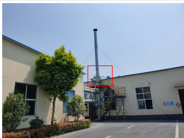
15m 高排气筒及在线监测设施
