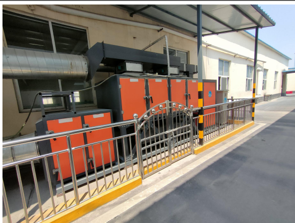
有机废气处理设施 (活性炭吸附+催化燃烧系统(TA001)工艺)
